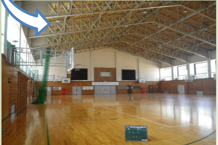
一階屋内運動場 工事後
